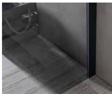
Napojení skla do přístěného profilu
